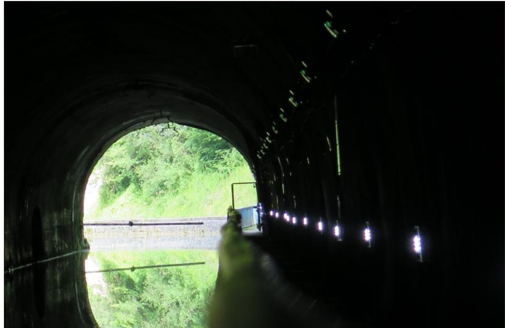
■ Ouvrage remarquable de 4.877 m, second souterrain fluvial français, le tunnel de Mauvages est exceptionnellement ouvert au public.
